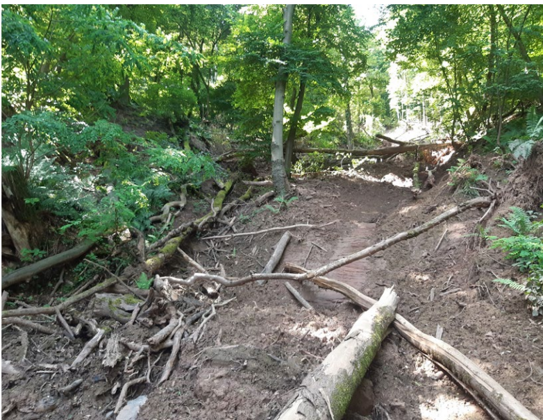
Wasserrinne und lose Stämme und Äste, die auf die Fahrbahn rutschen können.
