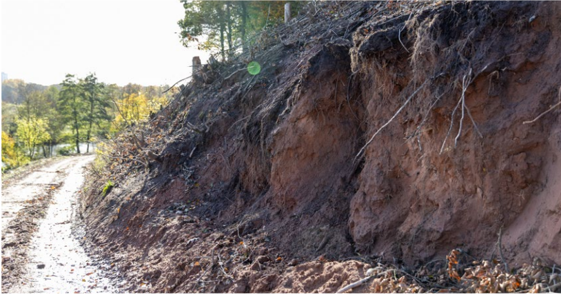
Weggespültes bzw. weggebrochenes Erdreich, durch das der Hang destabilisiert wird
