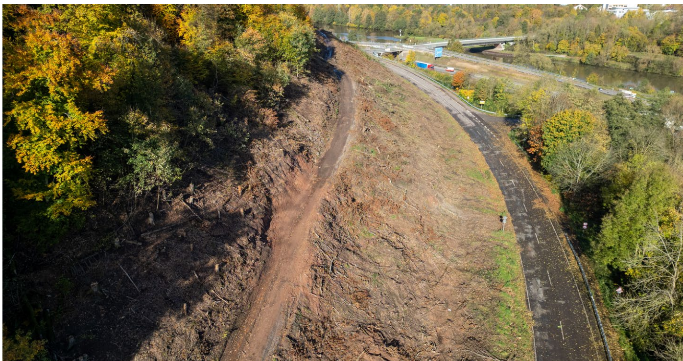
Hang mit vom Wasser abgetragenen/weggebrochenen Erdmassen. Bei künftigen Rutschen besteht die Gefahr, dass Erde, Bäume, Steine etc. über den Weg wie über eine Rampe auf die Fahrbahn geschleudert werden können. Foto: D. Bittner
